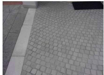
ESEMPIO DI MONTAGGIO CUBETTI
